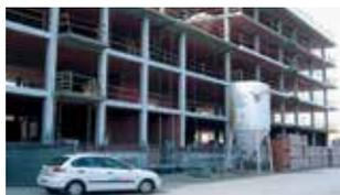
\*Los pilares y cantos de forjado son zonas propensas a crear puentes térmicos produciendo condensaciones y pérdidas de calor.
