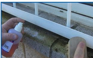
1. Limpiar la superficie donde deseamos colocar TQ BIRD STOP, ya sea piedra, madera, zinc, hormigón, etc. Para eliminar todo tipo de residuos orgánicos e inorgánicos utilizaremos TQ DESCANET DS.
