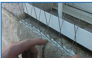
3. Posicionar TQ BIRD STOP y presionar consiguiendo que el cordón de TQ MASITOP emerja entre los orificios de la base. TQ BIRD STOP se coloca en el extremo de la cornisa dejando una separación de 2-3 cm entre tiras. Para cornisas anchas, si colocamos una segunda hilada de protección, dejar 19 cm de separación entre ambas.
