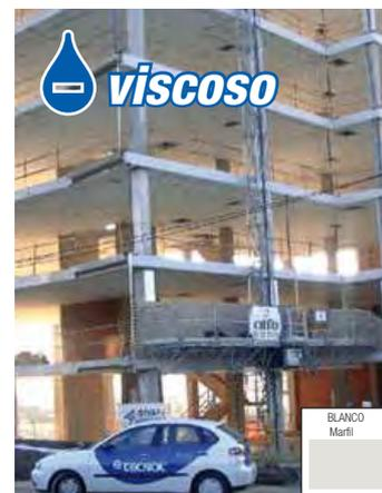
Los pilares y cantos de forjado son propensos a crear puentes térmicos produciendo condensaciones y pérdidas de calor.
